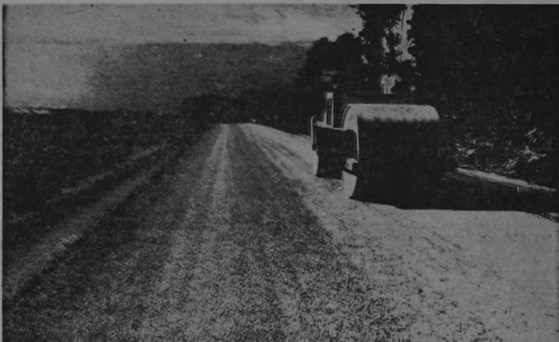
Maquinaria compactando pavimento en un sector de la carretera, cerca de la frontera con Panamá.
