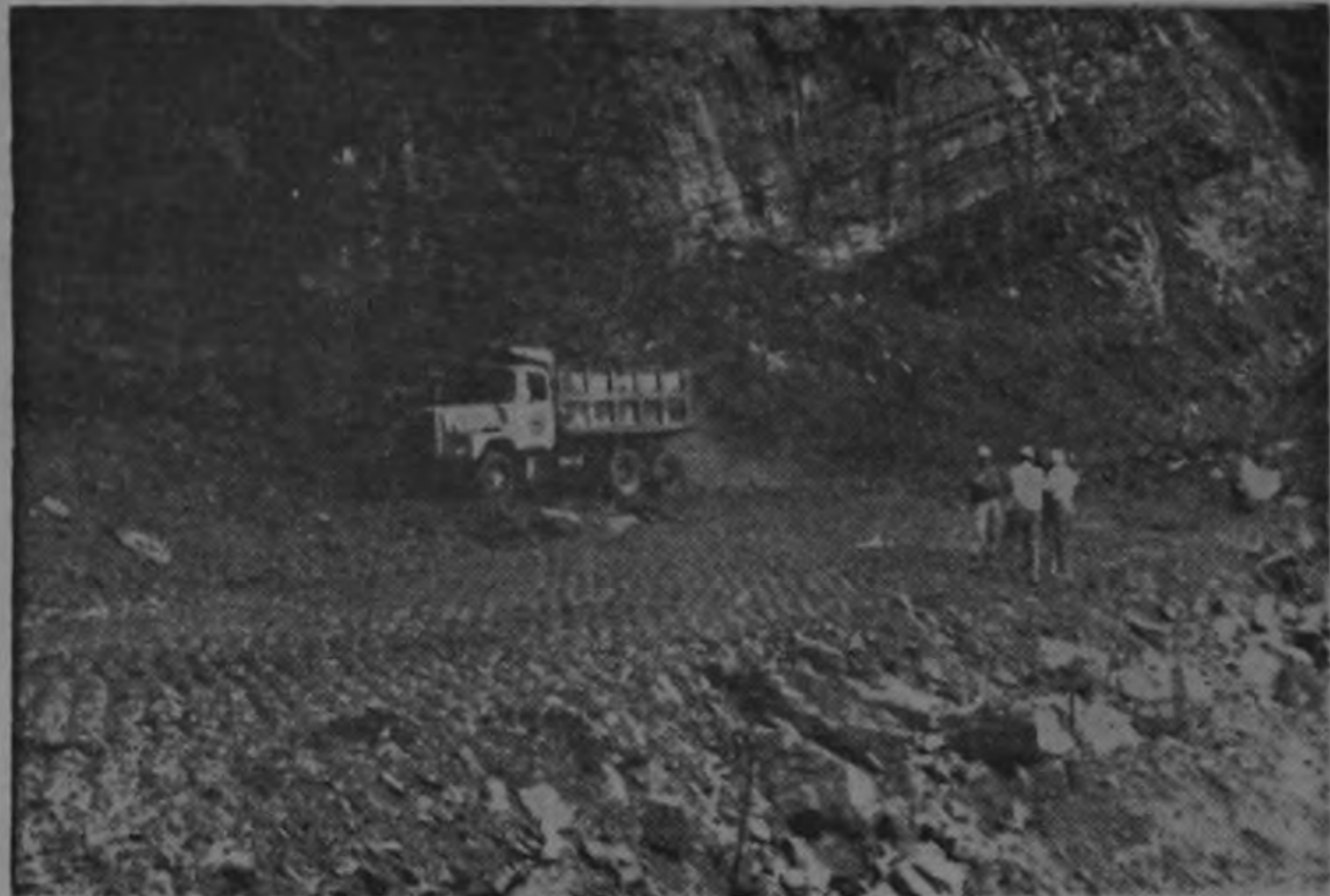
Corte en roca de una de las secciones de la Carretera a Panamá que construye la B. T. A. Este es uno de los tramos de más difícil ejecución que ha tenido que superar la Empresa Constructora.
